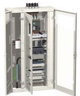
Caixilho suporte do espelho é giratório para acesso rápido aos equipamentos.
